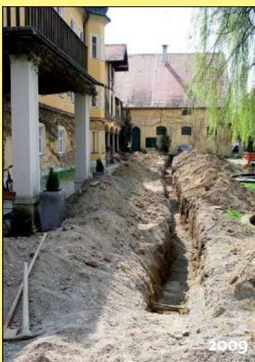
Bau der Ringleitung für die Pellets-Heizung
