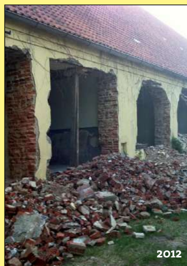
Umbau des Ökonomiegebäudes zum Bürotrakt
