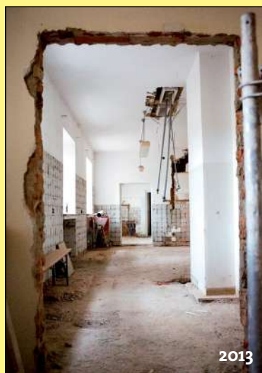
Umbau des Fuggerschlosses zum Hotel, hier: Entstehung der Lounge
