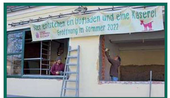
Die Biohof-Baustelle – links die Käserei, rechts der Hofladen
