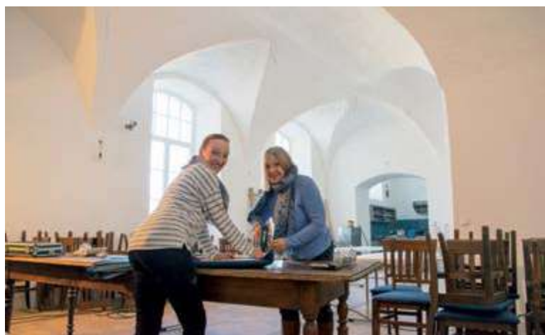
Der hohe Gewölberaum wird zu unserem Gemeinschaftsraum: oben werden die Stühle neu bezogen, rechts die Küche installiert.
