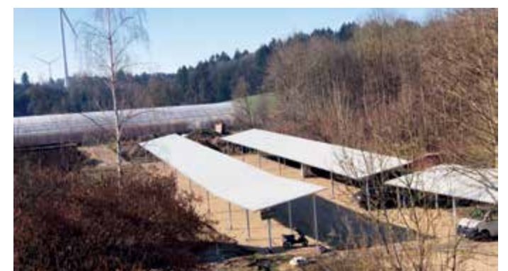
Der neue Solarcarport wartet noch auf seine Photovoltaik-Module
