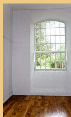
Der frisch renovierte und mit Fußbodenheizung ausgestattete Galerie-Raum
