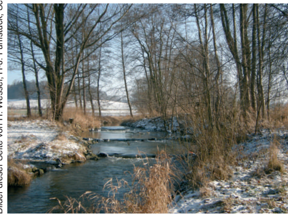
... diese Stufen wurden vom Wasserwirtschaftsamt rückgebaut und durch mehrere flache Sohlrampen ersetzt.
