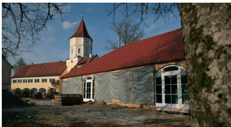
Die neu erstandene Remise, unser neuer Seminartrakt, fast fertig ...
