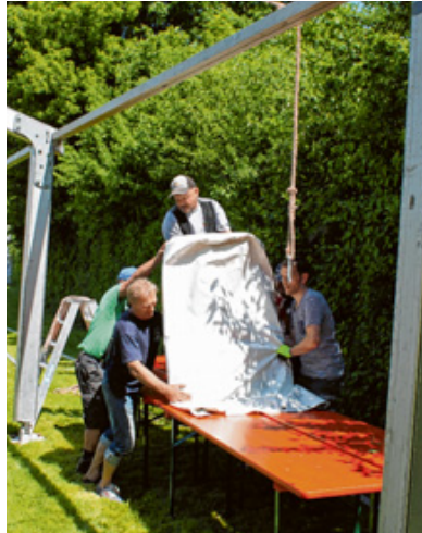
Der Aufbau läuft auf vollen Touren: Planenziehen der Helfer für das Festzelt in Unterbaar. Foto: Andreas Dengler
